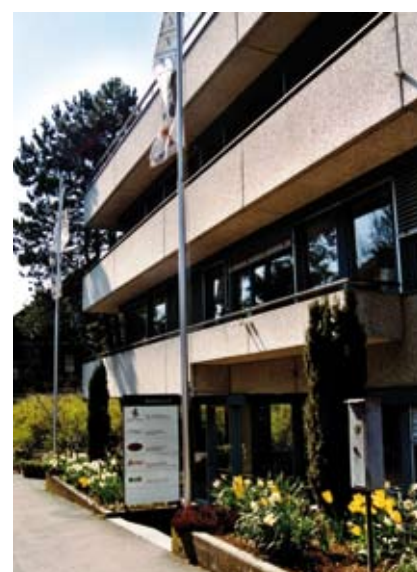
TSM siège à la Weststrasse 10, à Berne, depuis 1998.
